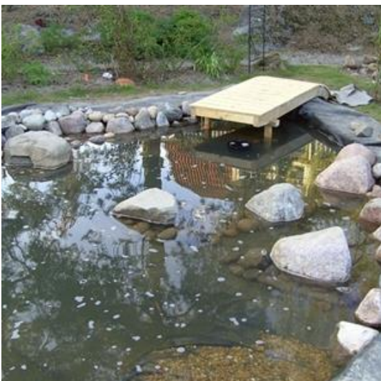
Kims nybyggda brygga vid Malmdammen
